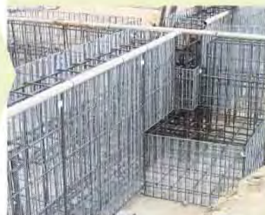
06 単管パイプ取り付け
