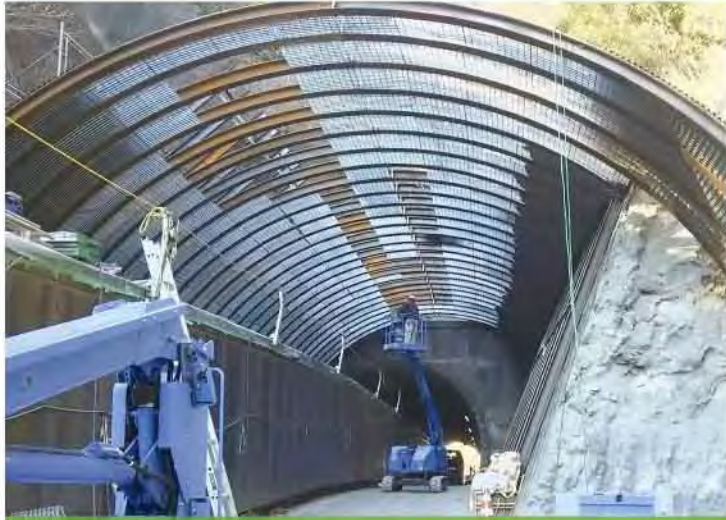
トンネル下地工法
