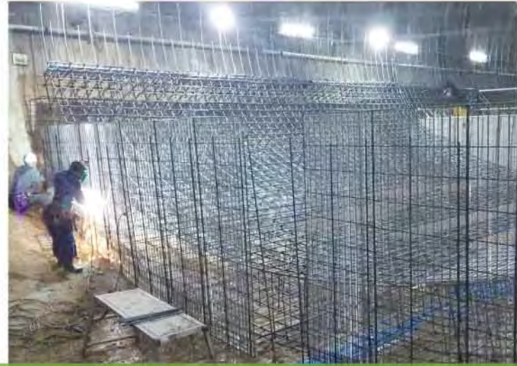
トンネル打継工法
