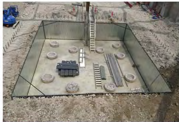
先行埋戻し工法 (鋼製型枠)
