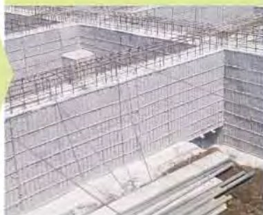
11 単管パイプ、栈木はずし
