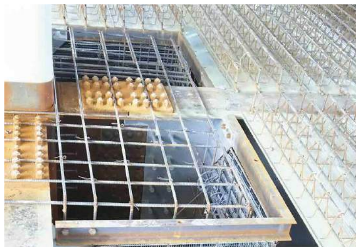
デッキのせ工法(鉄筋付デッキ)
