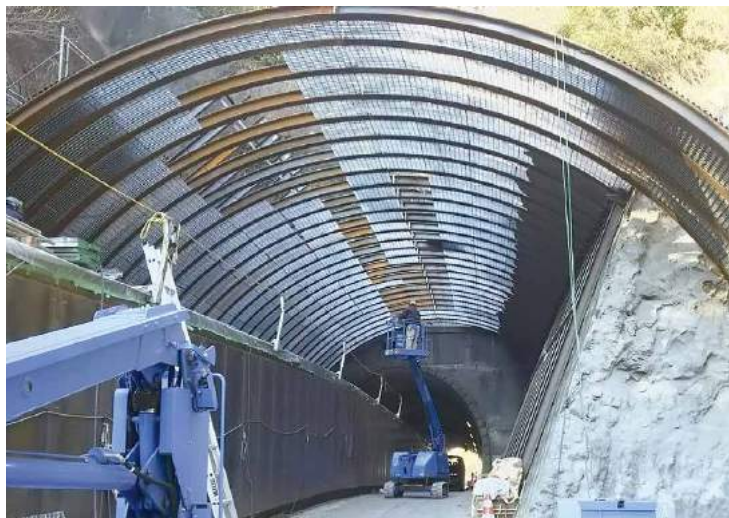
トンネル下地工法
