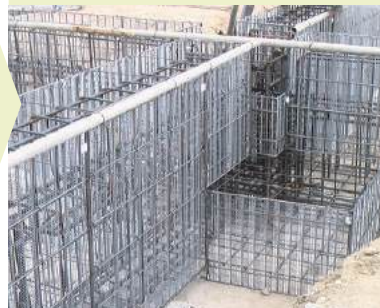
06 単管パイプ取り付け
