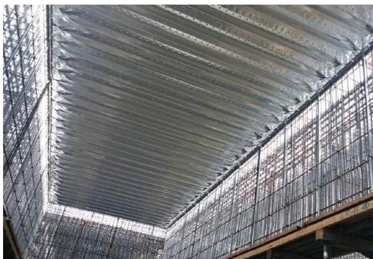
デッキのせ工法(フラットデッキ)
