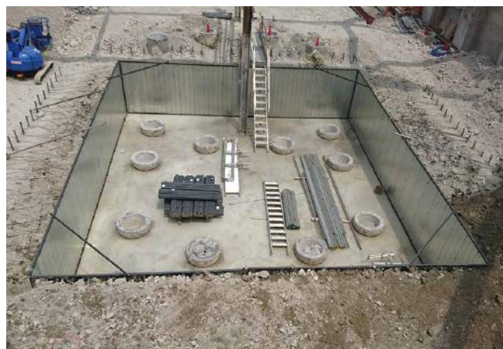
先行埋戻し工法(鋼製型枠)
