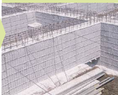
11 単管パイプ、栈木はずし
