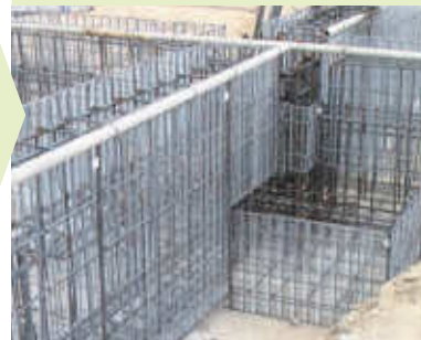
06 単管パイプ取り付け
