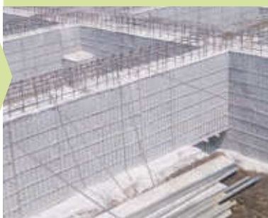
11 単管パイプ、栈木はずし
