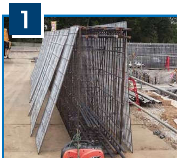
▲ パネル取り付け
